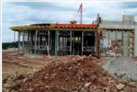
Das Erdgeschoss ist fertig (20.06.09)
